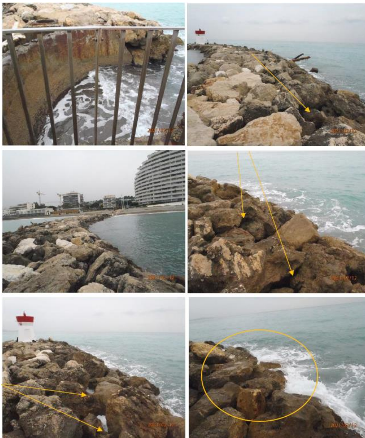
Figure 7 : Photos de la contre-digue (source : diagnostic visuel de la contre-digue du port de Marina Baie des Anges, JConseil 2021)
