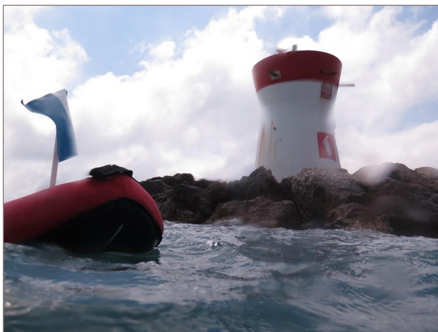
Figure 18 : Illustration du suivi de la digue réalisé le 03 juillet 2024 par les équipes de CREOCEAN
